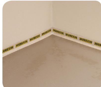
3. Všetky zvislé konštrukcie oblepíme obvodovou dilatačnou páskou. Optimálna teplota pre spracovanie nivelačných hmôt je medzi +16°C až +22°C. Minimálna odporúčaná teplota podkladu je +10°C.
