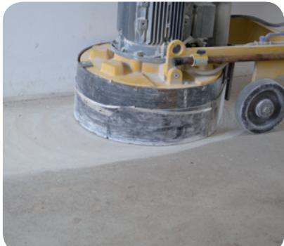
1. Podklad pod nivelačné hmoty musí byť súchý, nezmrznutý, nosný, tvarovo stály a bez nečistôt. Preto odporúčame podklad prebrúsiť a následne vysať.
