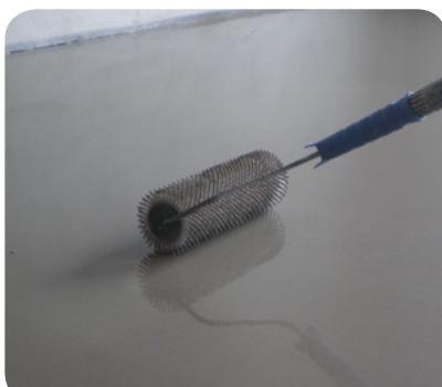
8. Hned po roztiahnutí nivelačnú hmotu odvzdušníme ježovým valčekom. Uvolníme tým uzavreté vzduchové bubliny pre dosiahnutie rovného a súvislého povrchu.
